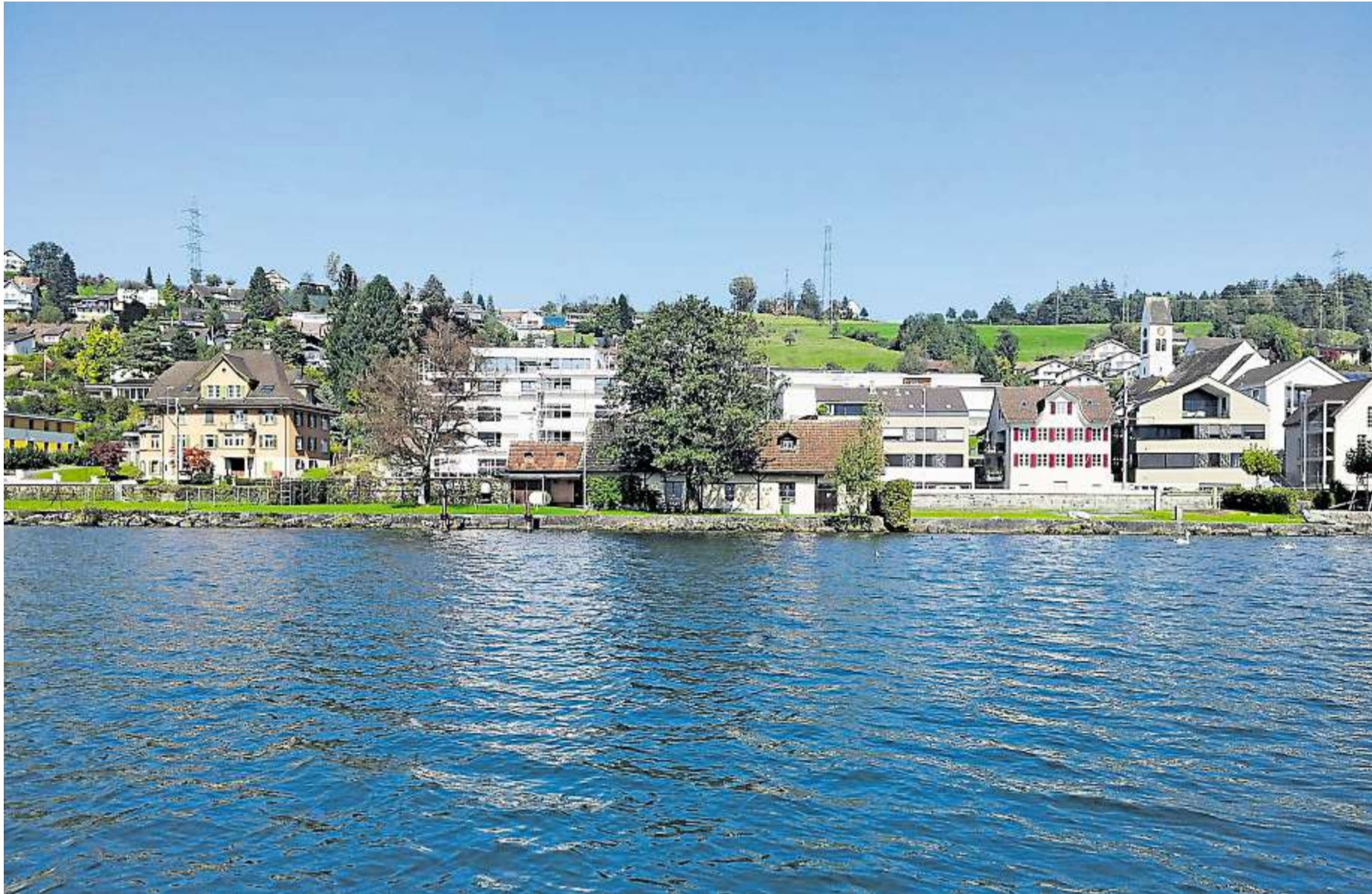
Die Liegenschaft alte Zementi liegt direkt am See. Auf dem Areal gibt es eine kleine Gewerbehalle (Bildmitte) und ein Wochenendhäuschen, leicht zurückversetzt.
